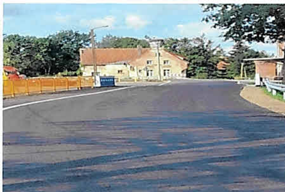
Remont drogi powiatowej nr 1582N na odcinku od DW594 w miejscowości Filipówka do miejscowości Linkowo - ETAP I
